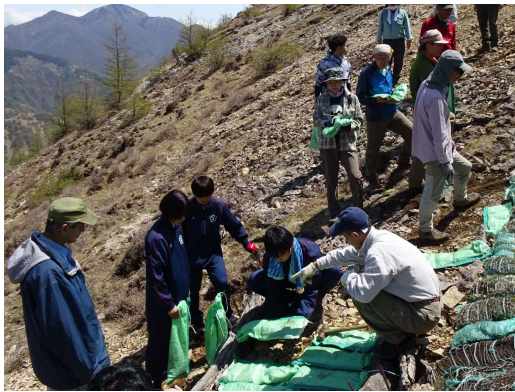
写真左：植生袋の貼り付け作業。（2023年4月）
