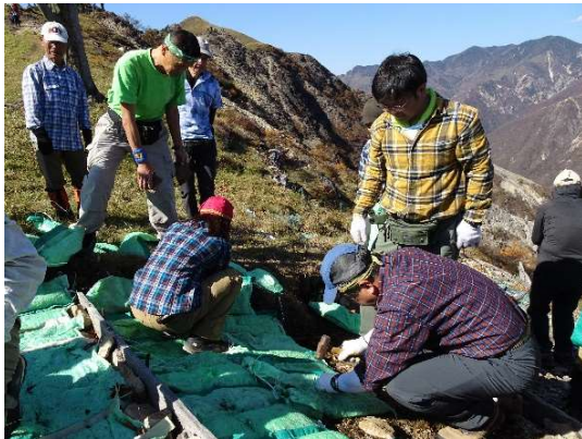
写真左：植生袋の貼り付け作業。(2023年11月)
