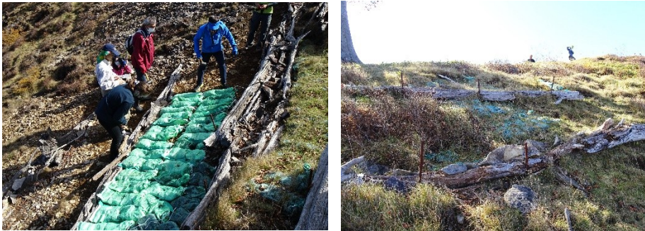
写真：植生袋の貼り付け。植生袋から草が生えて土砂流出を防いでいる様子。(2021年11月3日)
