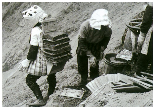
急斜面に植生盤を張り付ける当時の女性たち
