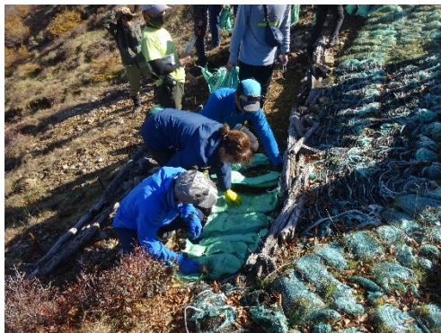
写真左：植生袋の貼り付け作業。写真右：植生袋貼り付け後。(2022年11月3日)
