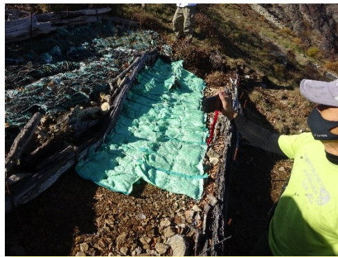
写真左：植生袋の貼り付け作業。写真右：植生袋貼り付け後。(2022年11月3日)
