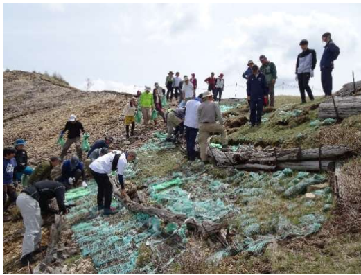
写真左：植生袋の貼り付け作業。(2024年4月)
