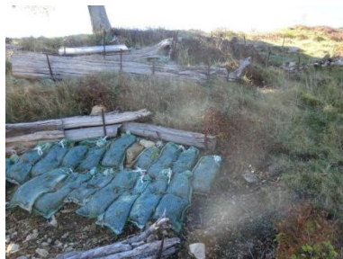
写真：植生袋から草が成長し土壌流失を止める：2021年10
