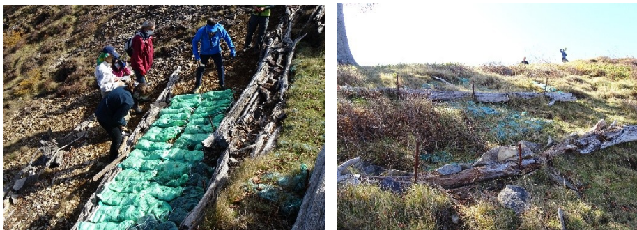
写真：植生袋の貼り付け。植生袋から草が生えて土砂流出を防いでいる様子。（2021 年 11 月 3 日）
